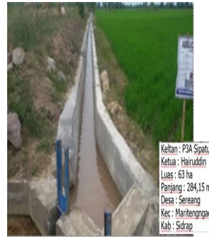
Gb. 7 Jaringan irigasi tersier dilengkapi pintu air
