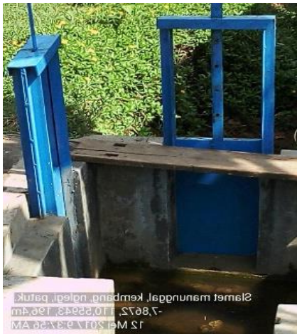
Gb. 5 Rehabilitasi pintu air
