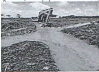
Pembuatan Saluran Pembuang Untuk
