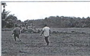
Penyisihan lapisan top soil (tanah pucuk);
