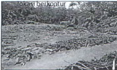
Pembuatan lahan berteras bangku ( bench terrace ) jika lokasi berkontur
